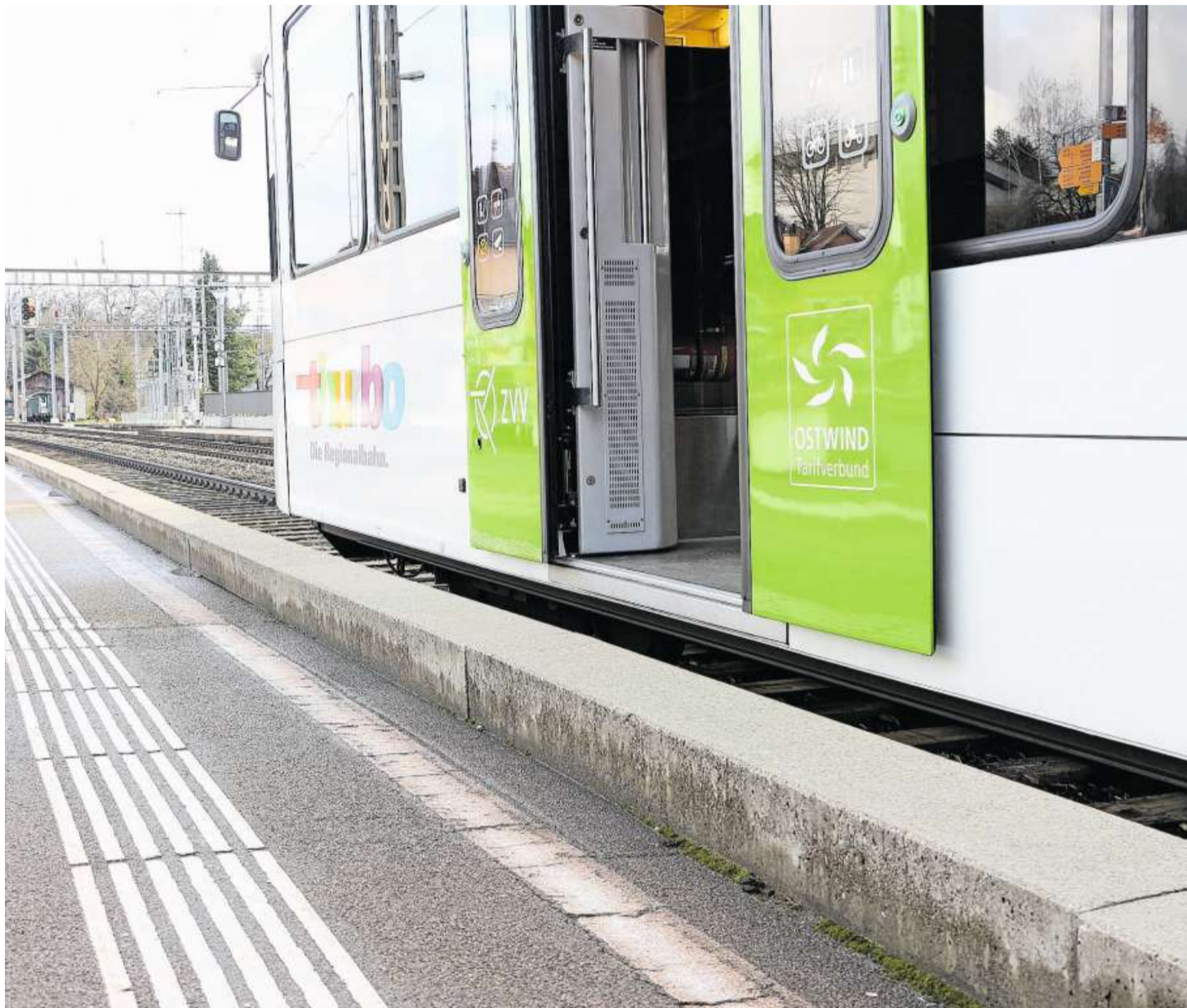
Die heutige Situation: Provisorische Betonelemente sollen das Ein- und Aussteigen erleichtern.
